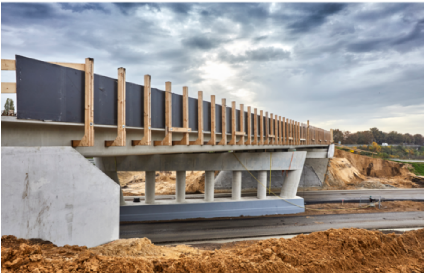
Het viaduct bij Varsen krijgt vorm
