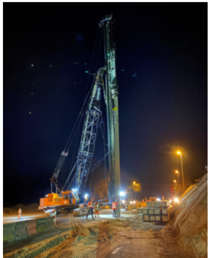
De eerste heiverzaamheden zijn al uitgevoerd
