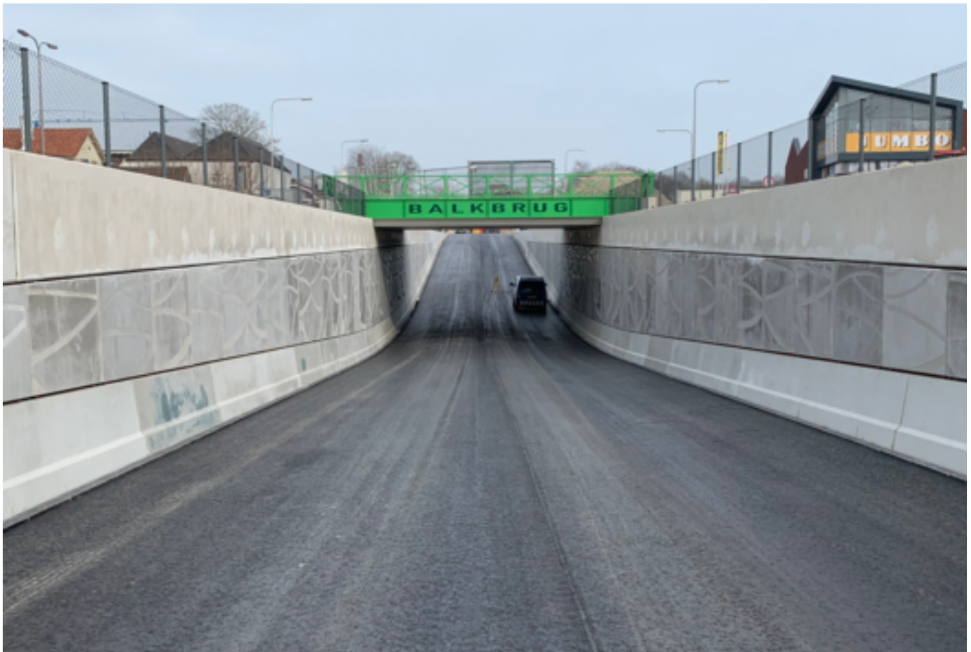
De onderdoorgang is zo goed als klaar voor gebruik
