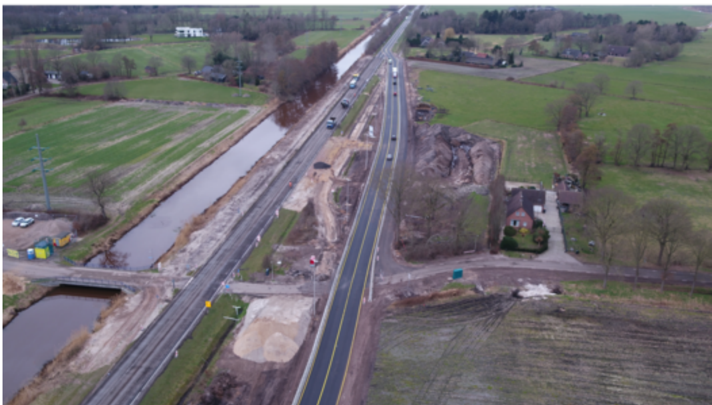
De N377 is tijdelijk verlegd, om bouwruimte vrij te maken
