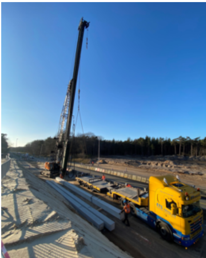
Heiwerkzaamheden bij het toekomstige ecodeuct Vlierbelten
